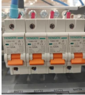
Şekil 4 Güç Kaynağı Akü Sigorta Bağlantısı
