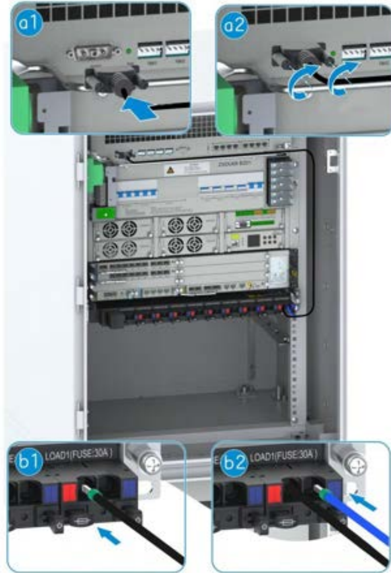
Şekil 15-55 Fan Çekmecesinin Güç Kablosunun Takılması
