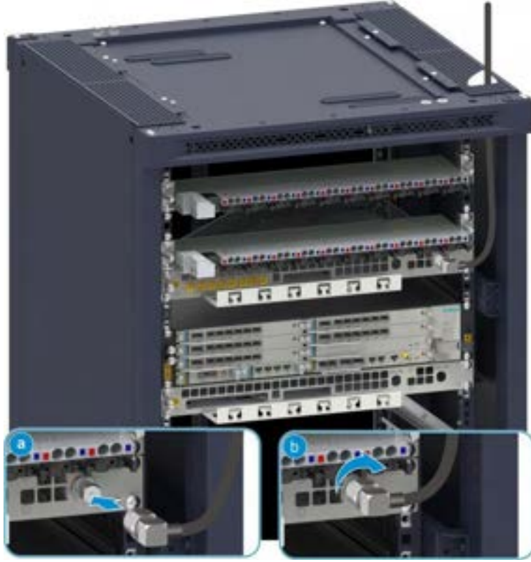
Şekil 12-27 GPS Feeder Kablosunun Bağlanması
