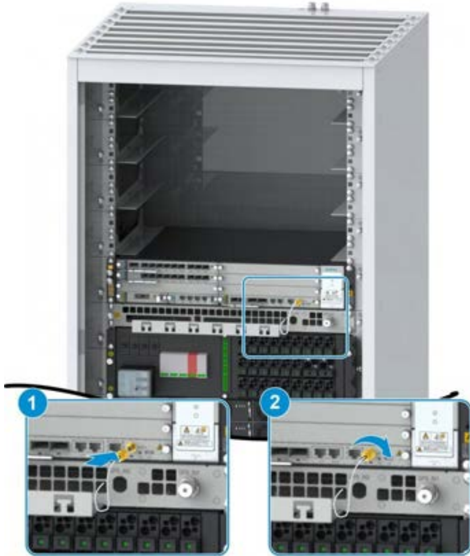
Şekil 14-19 GPS Jumper Kablosunun CH1 Arayüzüne Bağlanması
