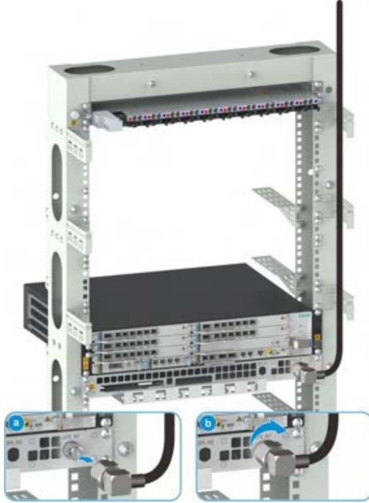
Şekil 17-16 GPS Feeder Kablosunun Bağlanması
