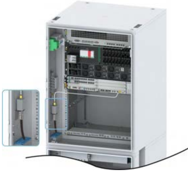
Şekil 16-40 GPS Feeder Kablosunun Bağlanması
