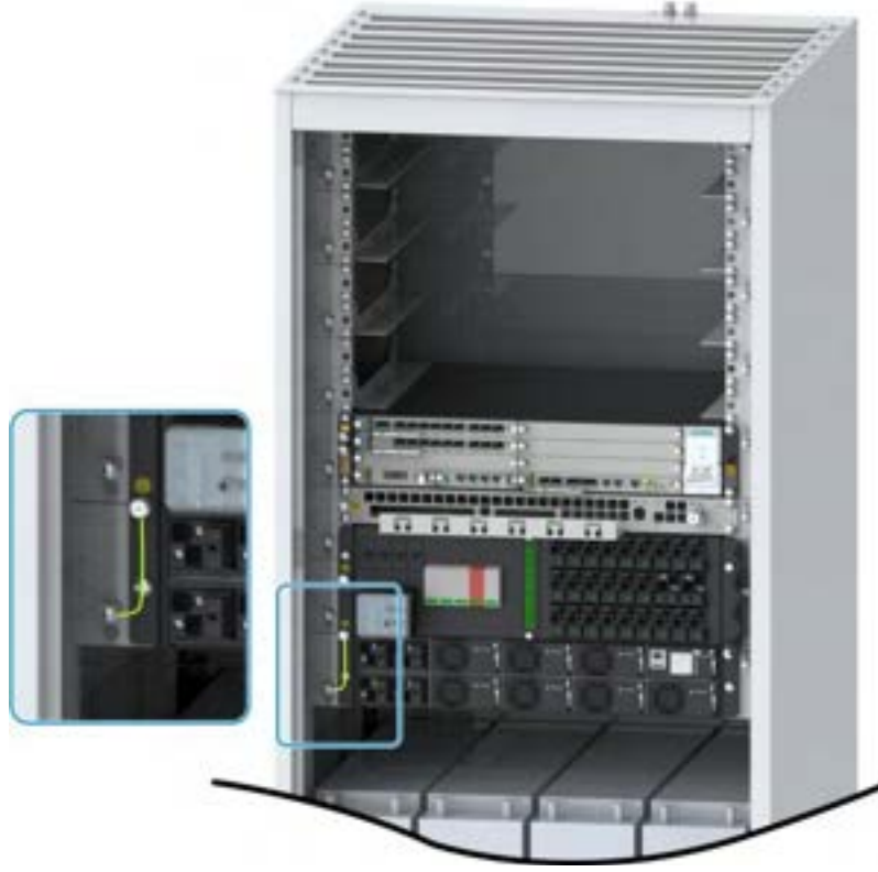
Şekil 14-18 B351'in PE Kablosunun Kurulumu
