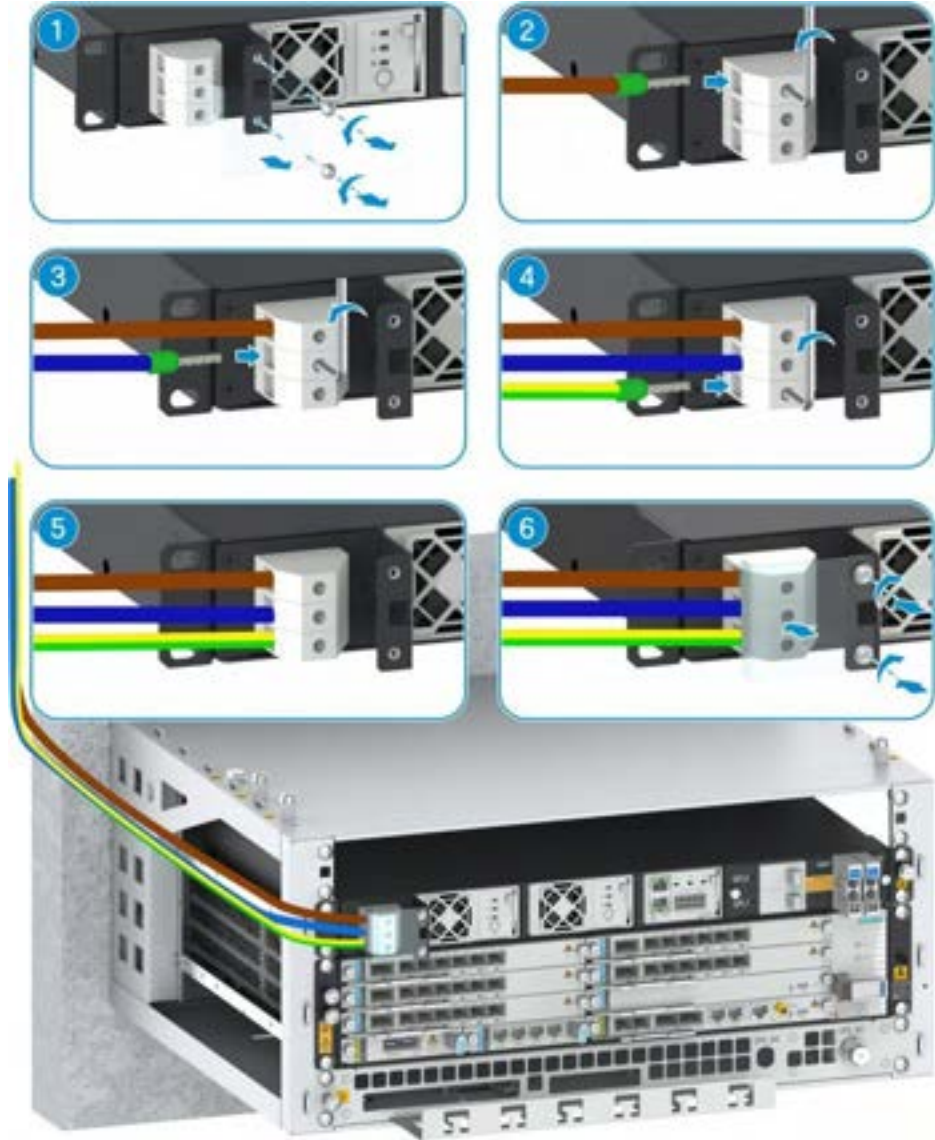
Şekil 9-39 B101'in Güç Kablosunun Takılması
