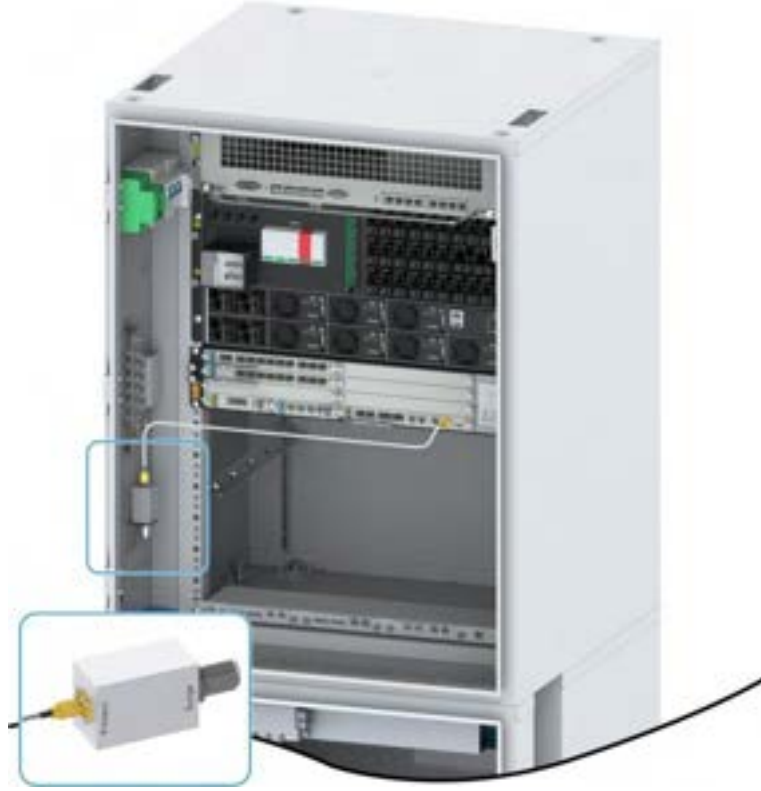
Şekil 16-38 RF Kablosunun CH1 Arayüzüne Bağlanması
