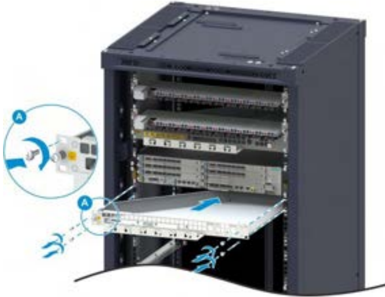
Şekil 12-21 VC9180 Kabinetinde Kablolama ve Havalandırma Biriminin Kurulumu
