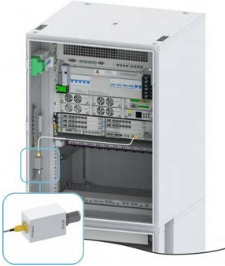
Şekil 15-42 RF Kablosunun CH1 Arayüzüne Bağlanması
