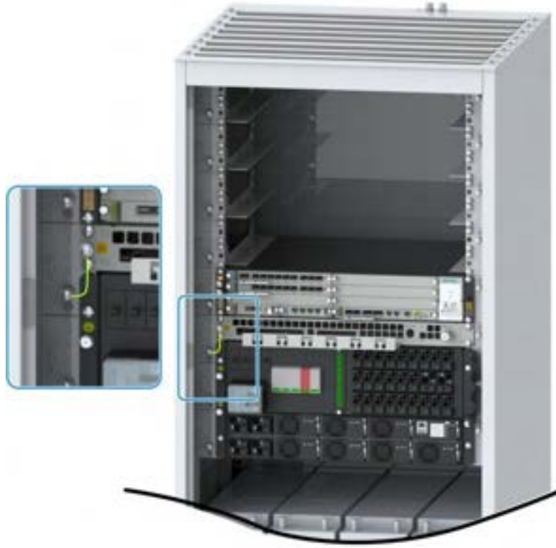
Şekil 14-17 Kablolama ve Havalandırma Biriminin PE Kablosunun Montajı
