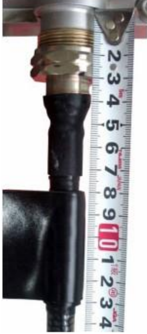
Şekil 15-5 Su Geçirmez Bandın Sarılması
