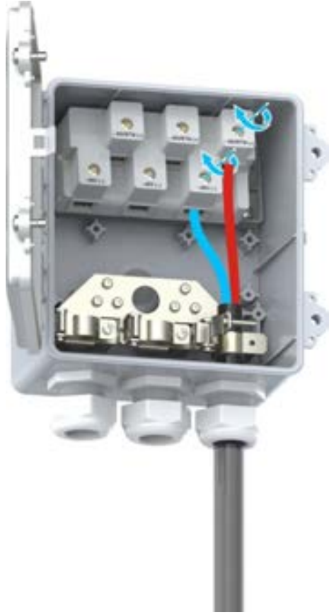
Şekil 10-34 Kablo Terminallerinin Takılması ve Kilitleme Vidalarının Sıkıştırılması
