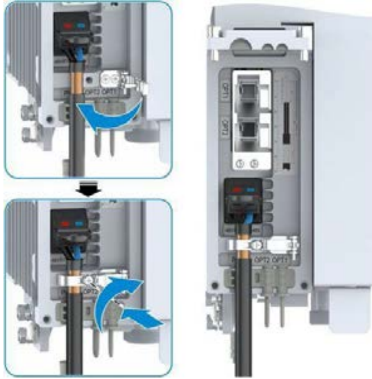
Şekil 11-15 Güç Kablosunun Sabitlemesi
