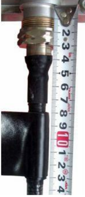
Şekil 16-5 Su Geçirmez Bandın Sarılması
