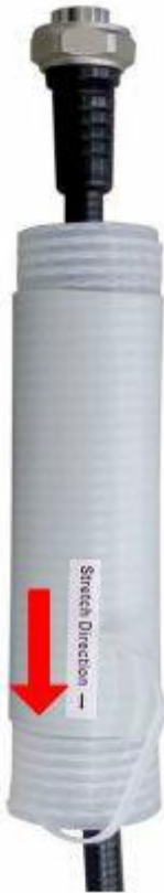
Şekil 15-3 RF Jumper'ın Soğuk Büzüşmeli Tüp İçerisinden Geçirilmesi
