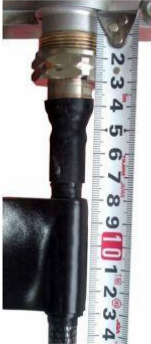
Şekil 15-5 Su Geçirmez Bandın Sarılması
