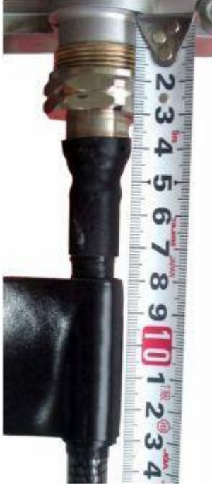
Şekil 17-3 Su Geçirmez Bandın Sarılması
